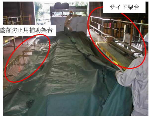
シート掛け作業風景
